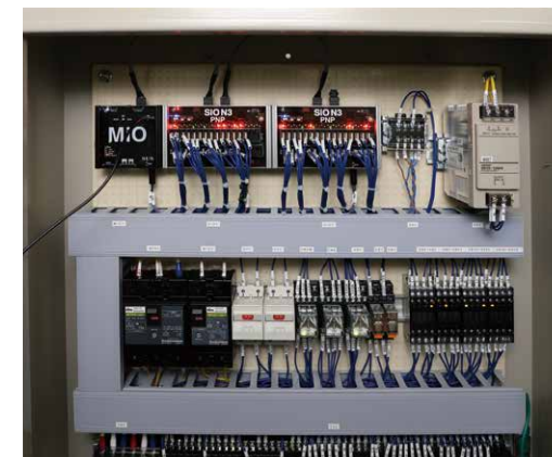
エアブロー用ロボットの初号機ではセンサやスイッチなど多数の機器との連動が必要となるため、MiOで入出力点数を確保している。
