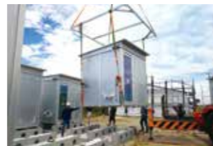
クレーンでユニットをつり上げ、短時間で設置や移設を行うことができます。
