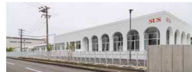
事業所と道路の境目に設置されたアルミフェンス。地域の景観との調和も考え、見通しがよくすっきりとしたデザインに仕上げました。
