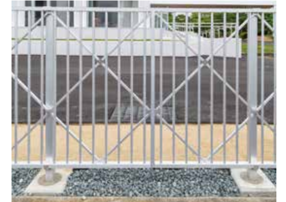
外側を囲う枠に垂直および斜め方向の格子を付けてパネルを構成し、柱材で地面に固定。斜めのフレームには面材を補強する役割もあります。
