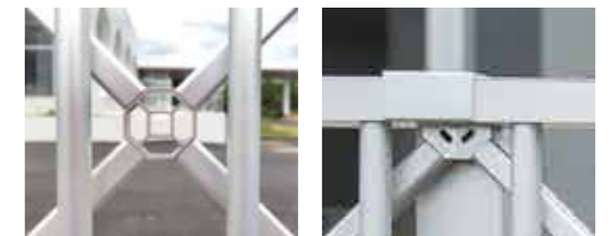
連結用のブラケットも押出材を加工して製造。斜めフレームの連結部分には押出材の断面を見せ、デザインのアクセントにしています。
